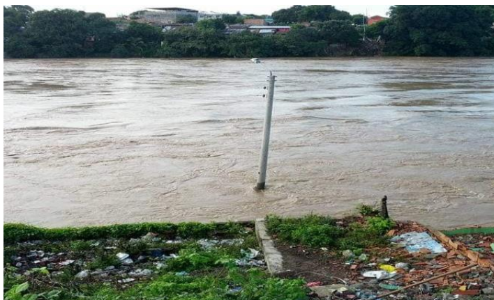
Figura 38 . Redes de energía afectadas por la inundación.
