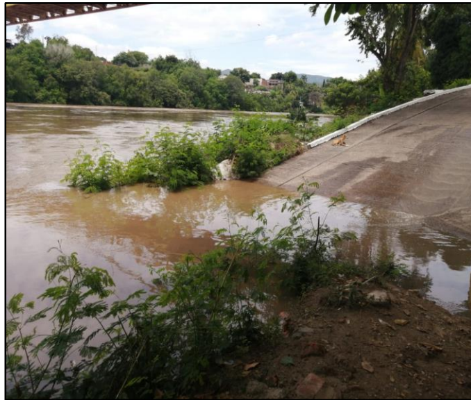
Figura 9 Vía de Ingreso a Puerto Montero. Sector que limita con Barrio San Miguel. Febrero de 2021; marzo de 2021
