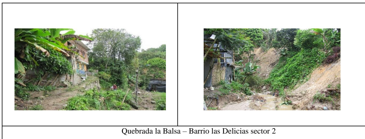
Figura 47. Condiciones de ocupación y afectación por deslizamiento
