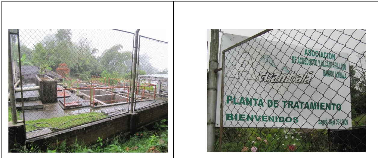
Figura 38. Acueducto comunitario Acuambalá, quebradas Las Panelas y Las Delicias
