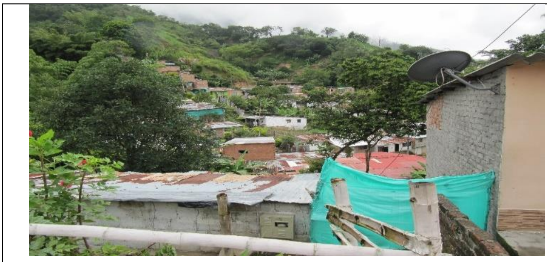
Figura 39. Viviendas ubicadas en la malla verde - quebrada Las Balsa
