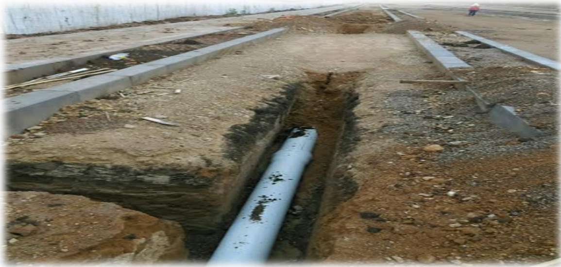
Imagen 5 Construcción red agua potable
