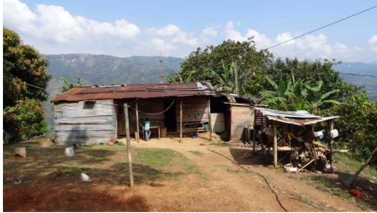
Foto 2. Fachada vivienda Resguardo de Suratena. 2017
