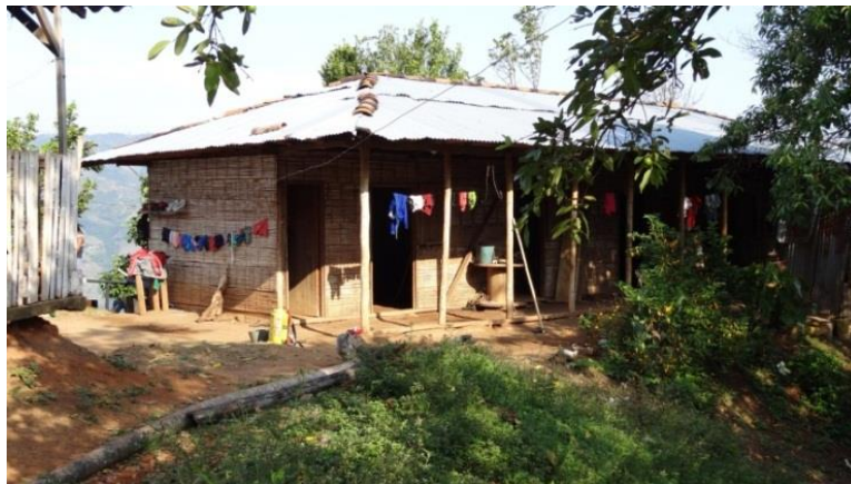
Foto 20. Vivienda sobre el piso con porche. Resguardo indígena de Suratena. 2017
