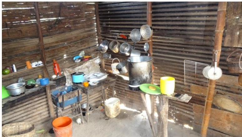
Foto 11. Cocina vivienda Resguardo. Vista 2. Paredes de esterilla/zinc, mesón elaborado en madera. 2017
