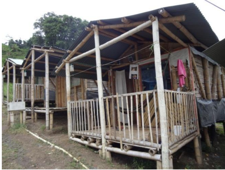
Foto 19. Vivienda sobre pequeños pilotes con porche. Asentamiento indígena Flor del Monte. Vereda La Florida, Belén de Umbría Risaralda. Foto: M. Arango. 2013
