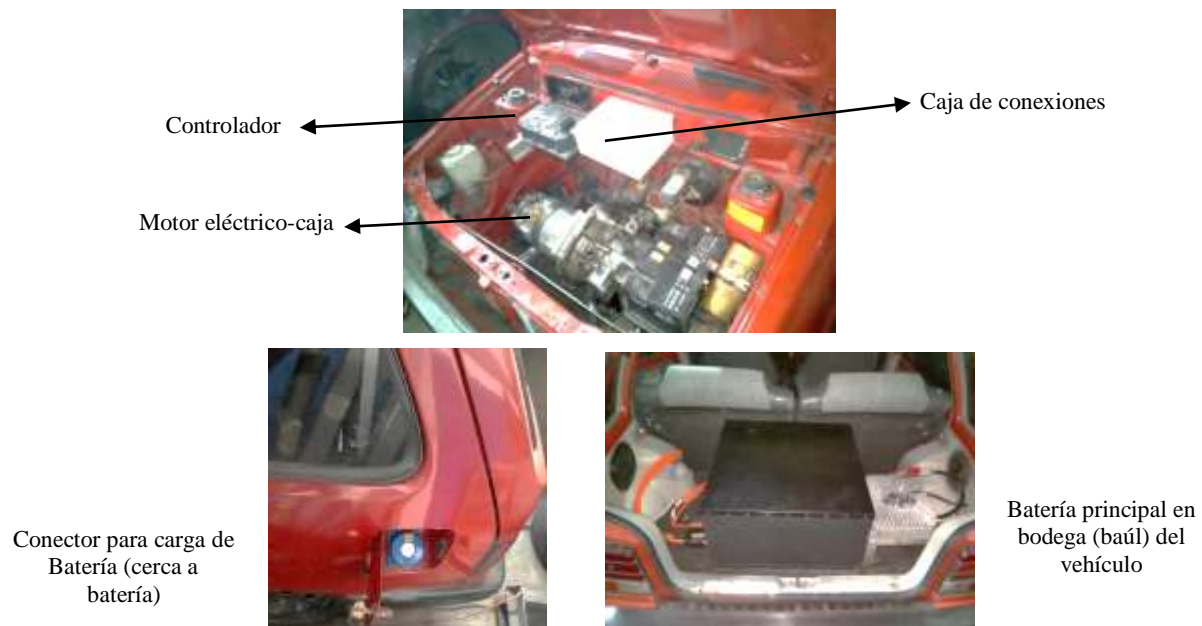
Figura 12: Ubicación de batería de litio y demás componentes
