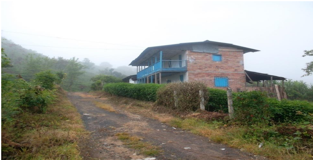
Imagen No. 11: Vía principal de la Vereda Santa Emilia. Fuente: Construcción propia. 2013
