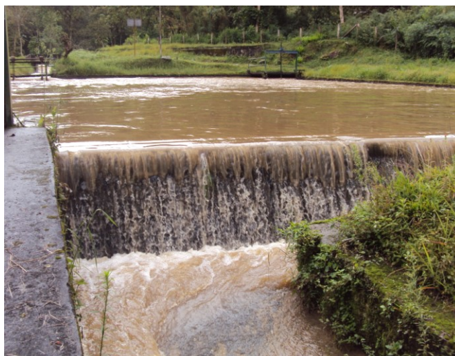
Foto No. 3. Sector Bocatoma CHEC Subestación Marmato. Archivo propio
