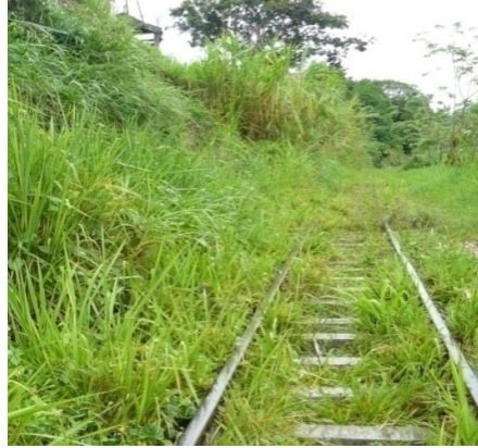
Foto No. 2 Tendido férreo en el Km. 41. Manizales. Fotografía archivo propio
