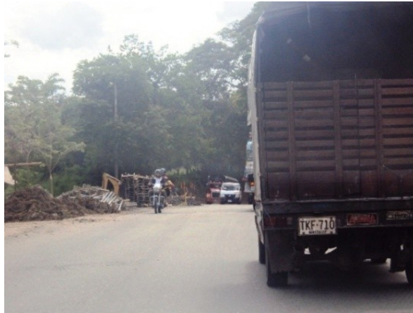
Foto No. 6 Sector Tres Puertas. Reparaciones en la vía. Archivo propio.
