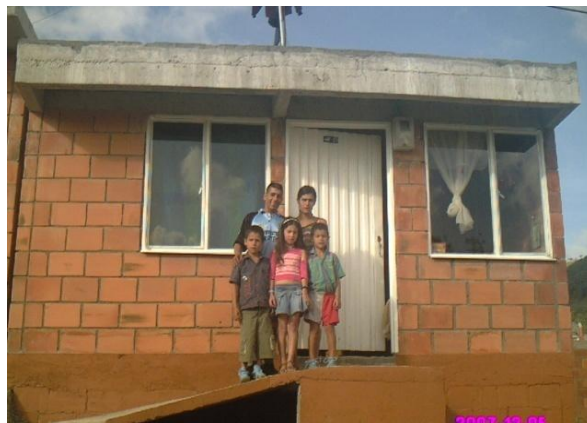
Figura 35. Vivienda nueva en San Sebastián. Fuente: Tomada por la autora.
