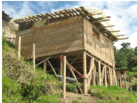
Figura 47. Vivienda típica del sector construida en esterilla y guadua. Fuente: Tomada por la autora.
