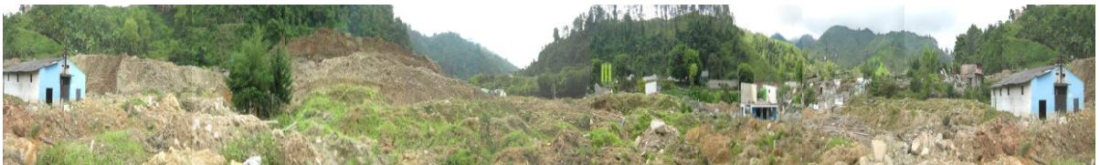
Figura 42. Panorámica barrio La Playita después de la demolición. Fuente: tomada por la autora
