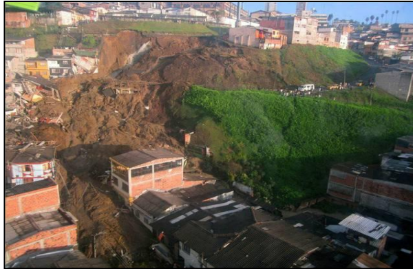
Figura 2. Deslizamiento en el barrio Cervantes – Manizales
