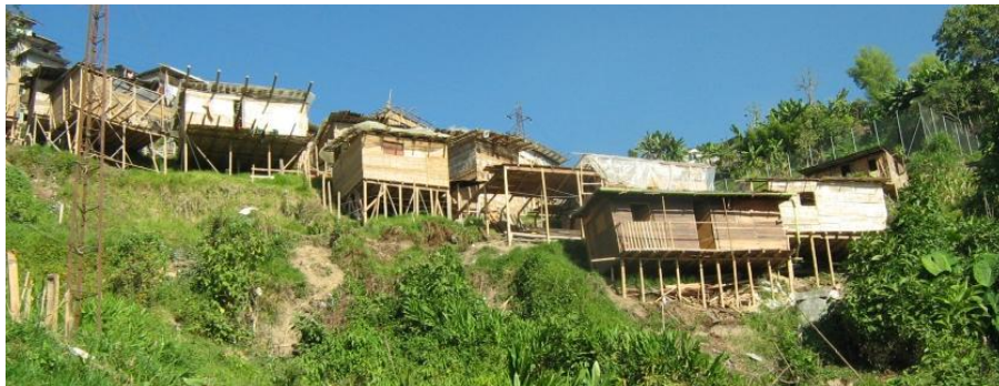
Figura 48. Panorámica barrio Bajo Andes. Fuente: Tomada por la autora
