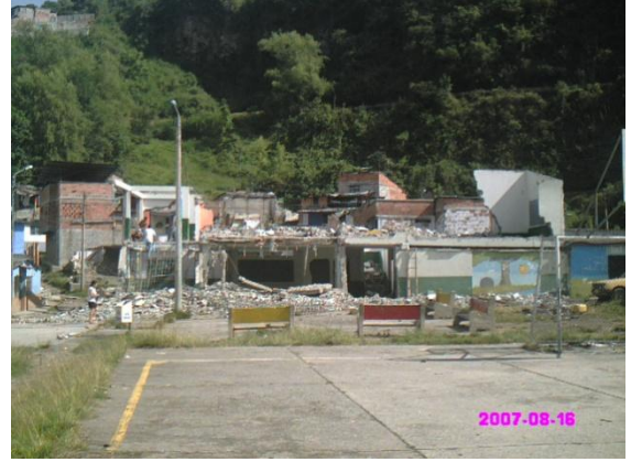
Figura 40. Colegio demolido. Fuente: tomada por la autora.
