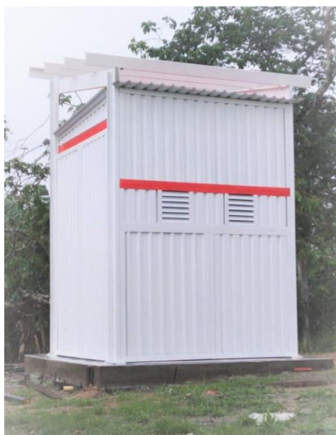
Figura 2. Caseta para almacenamiento de baterías
