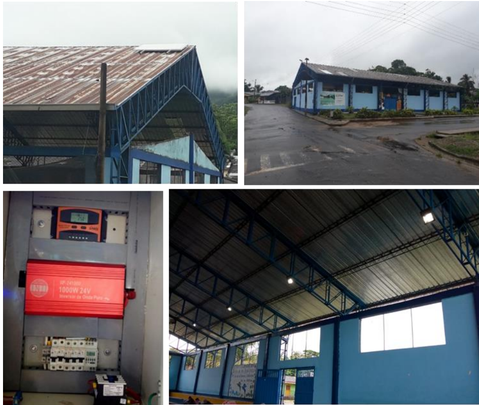
Fotografía 12. Coliseo Cubierto de Belén de los Andaquíes
