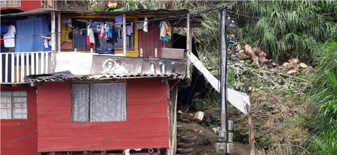
Fotografía 19. Riesgo por Deslizamiento sector Sub Andes.
