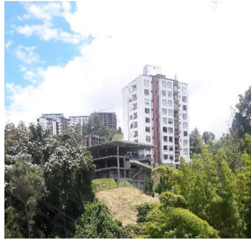
Fotografía 9. Imagen edificio ladera oriental.
