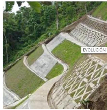
Imagen 76. Estabilización con pantallas y canales
