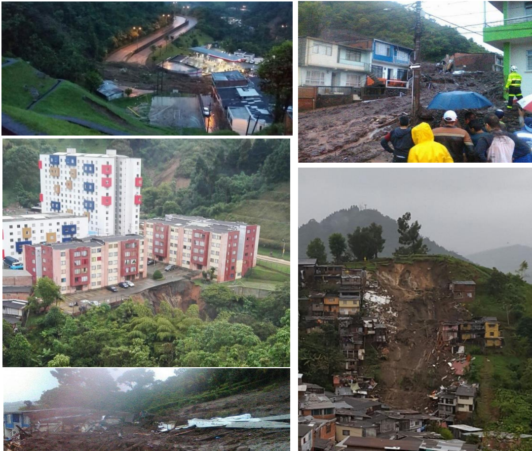
Fotografía 28. Emergencias en Manizales por deslizamientos en el 2017
