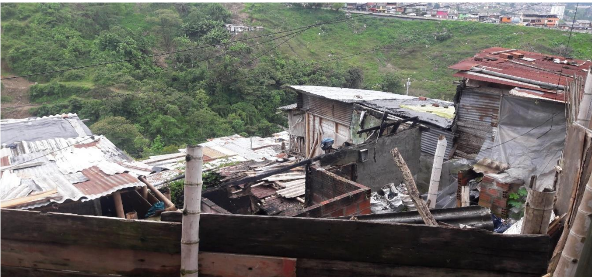
Fotografía 20. Escombros producto de un incendio, Bajo Andes.
