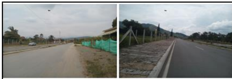
Foto 16 a la 30 vía Santaguada-Arauca, andenes, cerramientos, equipamiento.
