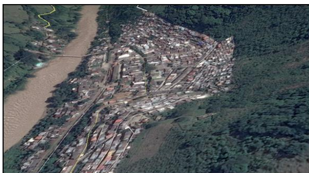
Foto 14 Densificación de la vivienda en la zona de ladera y a borde del Río Cauca. Vivienda de uno, dos y tres pisos. Desarrollo físico espacial del Corregimiento de Arauca.
