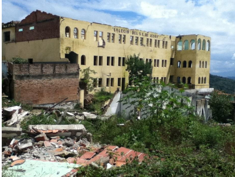
Foto 13. Colegio Sagrado de Jesús y casas vecinas destruidas
