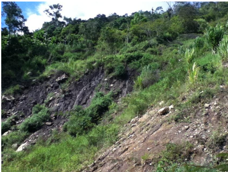
Foto 11. Deslizamiento paralelo al curso de la Quebrada Lagunetas.
