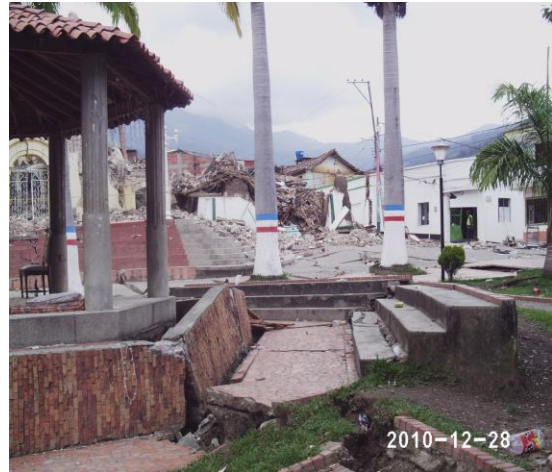
Foto 8. Afectación suelo urbano.
