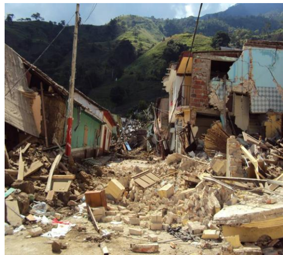
Foto 6. Afectación suelo urbano.
