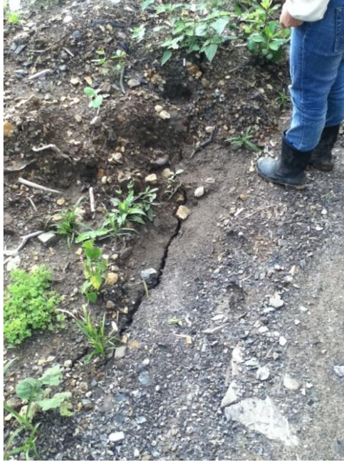
Foto 7. Agrietamientos del suelo en la parte alta del casco urbano. Vereda Jacome
