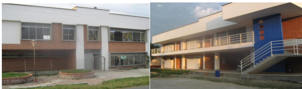
Sede Gabriela Mistral –Vista Externa –Construcción de 2011
