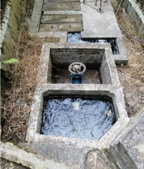
Figura 29. Válvulas de paso de la planta de tratamiento
