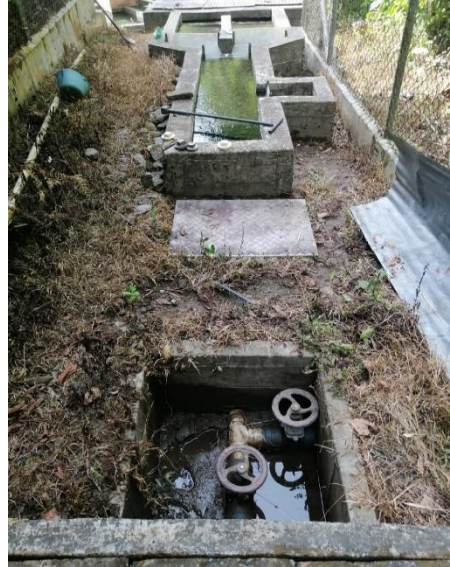
Figura 29. Válvulas de paso de la planta de tratamiento
