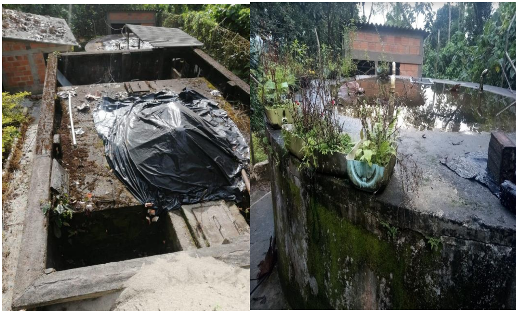
Figura 30. Tanques de almacenamiento
