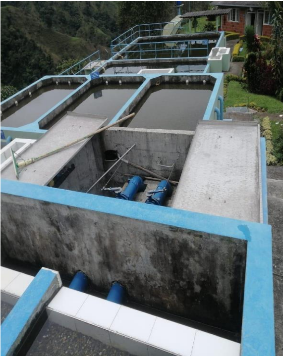
Figura 33. Sistema de filtración por múltiples etapas
