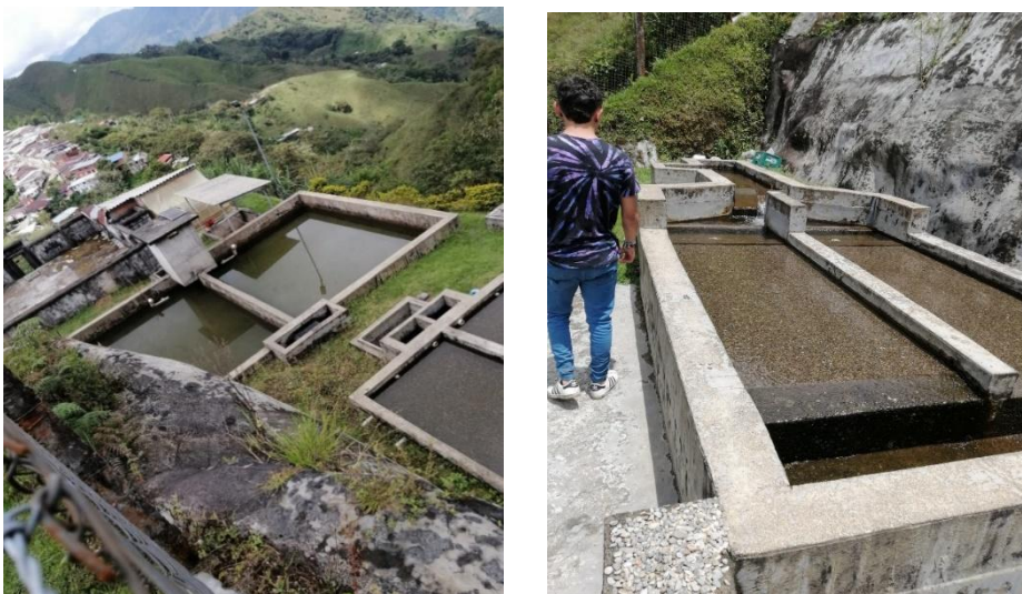
Figura 24. Sistema de filtración por múltiples etapas FIME
