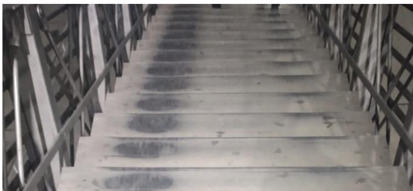
Ilustración 10 Fotografía escalares de acceso a una estación de Transmilenio
